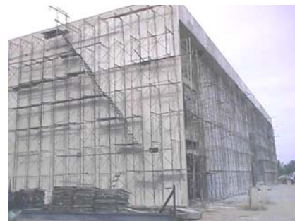
Fig. 1 TMEC Construction site (August 99)
