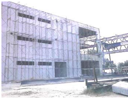
Fig. 2 TMEC Construction site (August 99)
