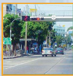
อุปกรณ์นับเวลาสัญญาณไฟ
