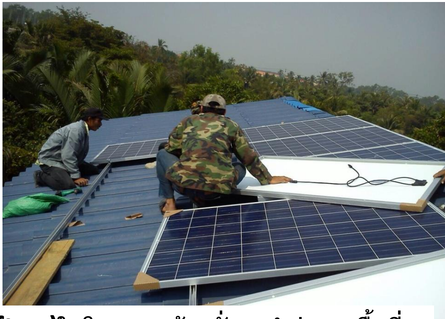
การติดตั้งแผงโซลาร์เซลล์ (Solar Rooftop) ในโครงการบ้านมั่นคงนำร่อง 4 พื้นที่
