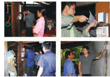
การติดตั้งเครื่องโซลาร์โฮม
