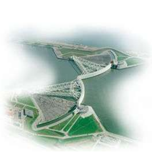
ภาพของประตูกั้นน้ำ "Maeslant Barrier"
